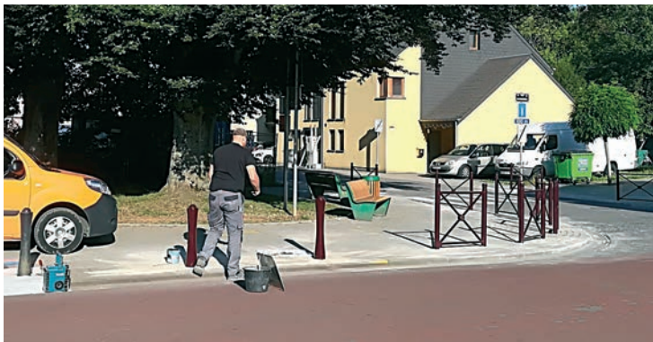
Placement de barrières à la rue Cockerill à Athus.
